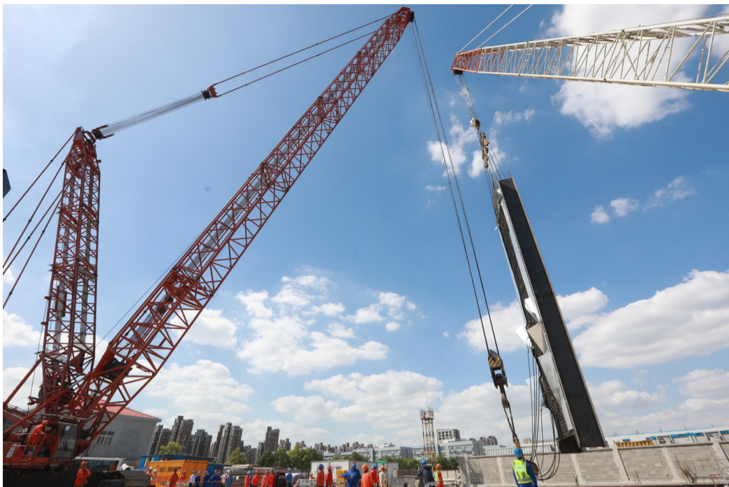
机场线首幅钢筋笼在梅富路起吊
